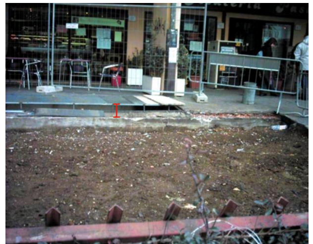
Fig. 8 – Abbassamento del piano di calpestio rispetto alle griglie in ferro del portico di un edificio a causa del cedimento dello strato di fondazione. L'elemento rosso in figura mostra l'entità del cedimento.
