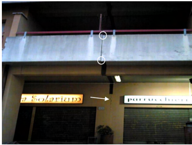
Fig. 6 – Danneggiamenti di un edificio causati dal cedimento differenziale delle sue fondazioni. Con i cerchietti sono evidenziati gli spostamenti relativi tra i due balconi, in origine affiancati, mentre la freccia indica una frattura formatasi nel muro sottostante.
