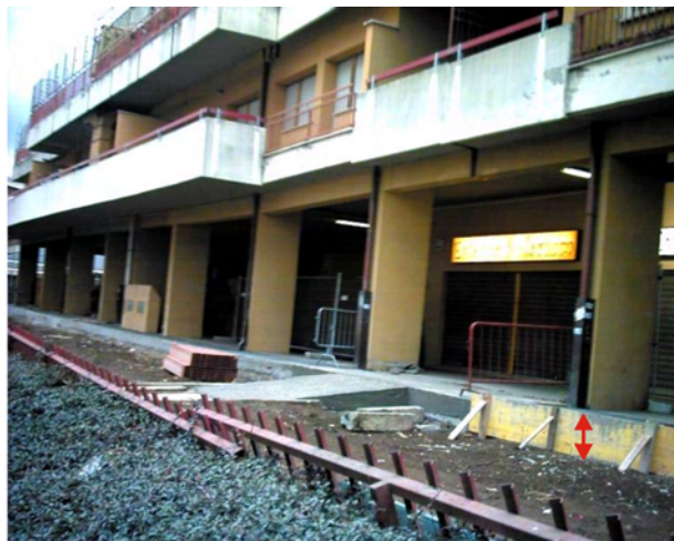
Fig. 7 – Abbassamento del piano di calpestio rispetto al piano in cemento armato dell'edificio per cedimento dello strato di fondazione. La freccia rossa mostra l'entità del cedimento.
