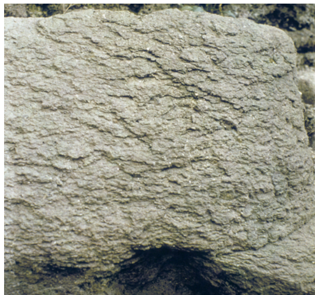
Fig. B-2 - Blocco di Cappellaccio, con tipico degrado superficiale. - A Cappellaccio block, with typical surficial degradation.
