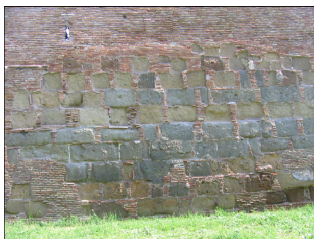
Fig. 4-7 - Mura Aureliane, con particolare dell'eterogeneità dei materiali tufacei utilizzati.
