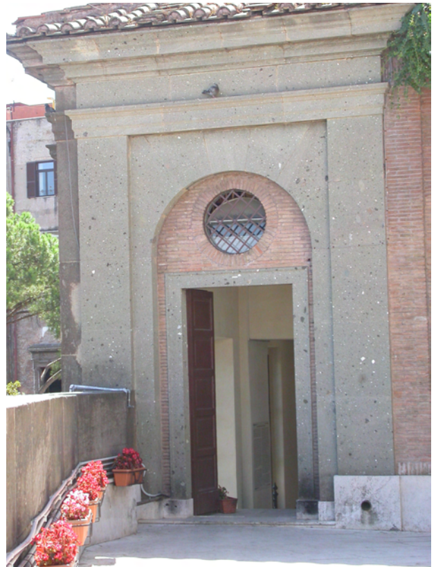
Fig. B-12 - Vittoriano, portale in lapis albanus , di cavatura moderna. - Vittoriano, a " lapis albanus " door frame, from a modern quarry.
