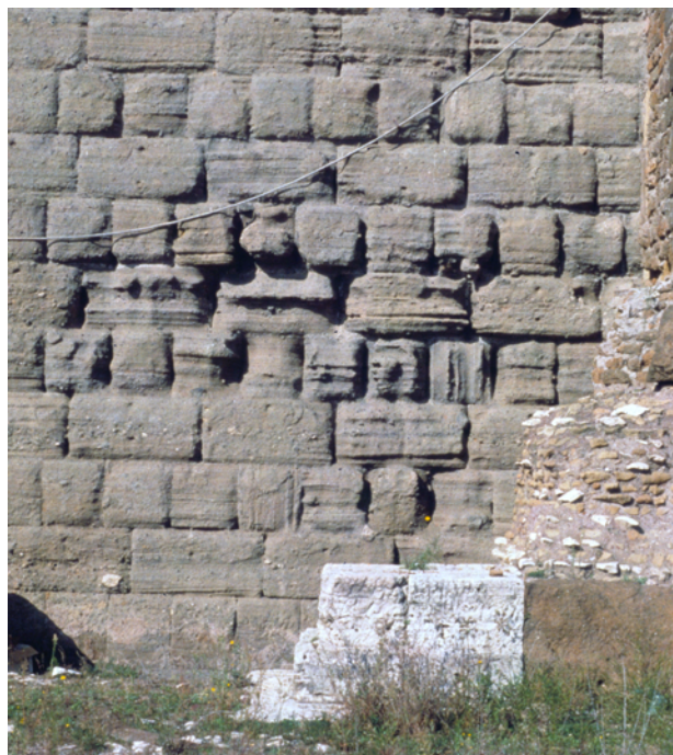
Fig. B-9 - Blocchi di lapis gabinus nelle mura del Campidoglio, disposti con la stratificazione sia in orizzontale che in verticale, con accentuati processi alterativi. - "Lapis gabinus" blocks of the Capitulum walls, positioned with the stratification both horizontal and vertical and marked alteration processes.
