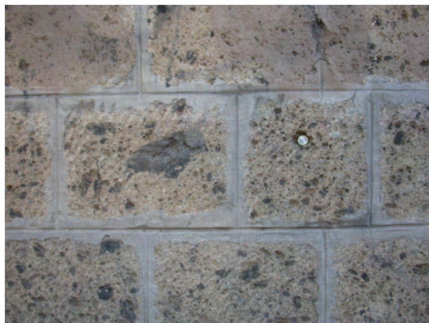
Fig. B-15 - Blocchi di Tufo Rosso a Scorie Nere in un muro moderno. - Blocks of Tufo Rosso a Scorie Nere in a modern wall.
