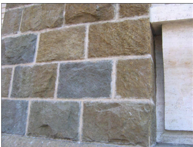
Fig. B-6 - Piazza Risorgimento, Museo storico dell'Arma dei Carabinieri; particolare dei conci in Tufo Sperone. - Detail of the Tufo Sperone blocks on the facade of the Museo storico dell'Arma dei Carabinieri.
