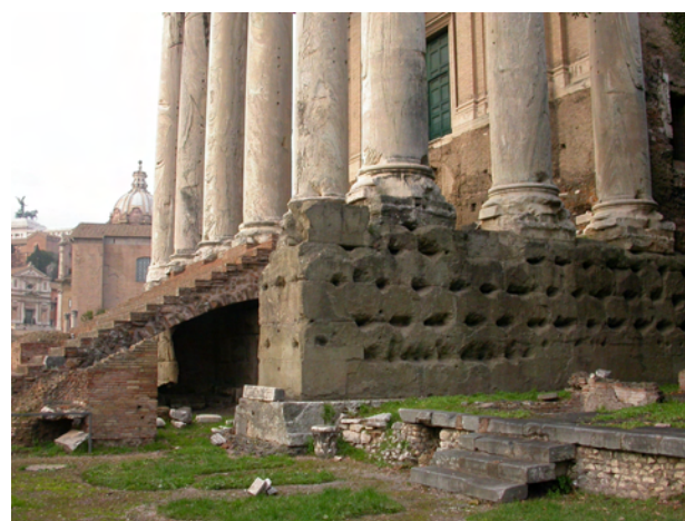
Fig. 3-4 - Nel Foro Romano, il Tempio di Antonino e Faustina con un basamento di blocchi di travertino sul quale si innalza una struttura in conci di lapis albanus , che sostiene le colonne di marmo cipollino.
