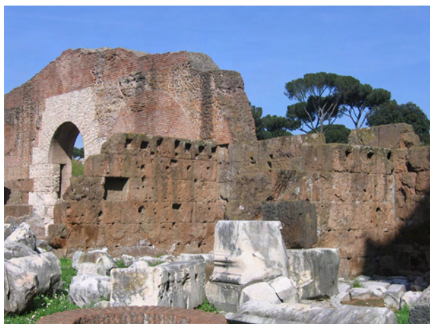
Fig. B-4 - Nel Foro Romano, un muro di grossi blocchi di Tufo Lionato. - In the Roman Forum, a wall of Tufo Lionato blocks.
