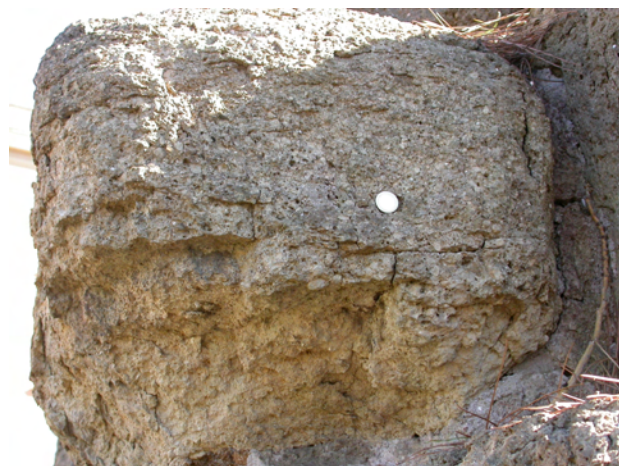
Fig. B-1 - Un concio delle Mura Serviane alla Stazione Termini; aspetti di deterioramento del Tufo Pisolitico.
