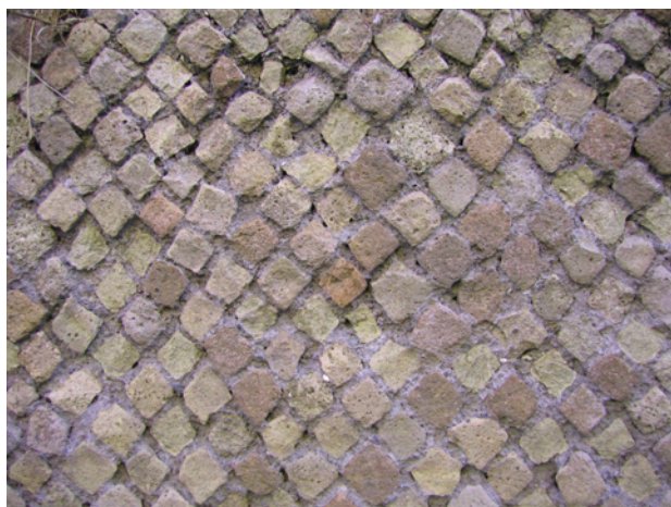
Fig. B-14 - Opus reticulatum in blocchetti di Tufo Giallo della Via Tiberina e di Tufo Lionato. - " Opus reticulatum " in blocks of the Tufo Giallo della Via Tiberina and of Tufo Lionato.
