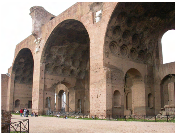
Fig. 4-1- Basilica di Massenzio, esempio di applicazione di opus latericium in strutture ad arco.
