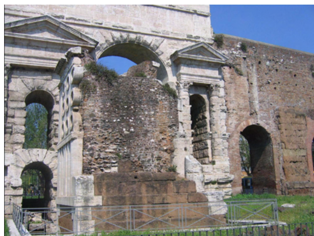
Fig. 4-5 - Porta Maggiore, accesso attraverso le Mura Aureliane, con strutture in tufo, laterizio e travertino.
