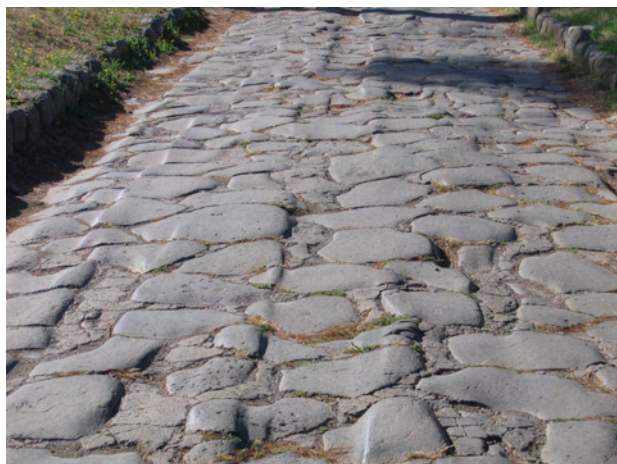
Fig. 3-1 - Il basolato dell'Appia Antica in blocchi di lava di Capo di Bove, con visibili le incisioni delle ruote dei carri.
