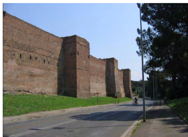
Fig. 4-6 - Un tratto delle Mura Aureliane verso l'Ardeatino con evidente la sovrapposizione di rifacimenti costituiti da laterizi diversi.
