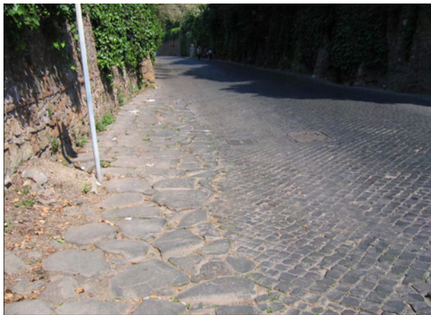
Fig. A-5 - Via di Porta San Sebastiano, pavimentazione stradale con basoli (a sinistra) e sampietrini (a destra). - Via di Porta S. Sebastiano, road paving with larger lava blocks ("basoli") and "sampietrini".
