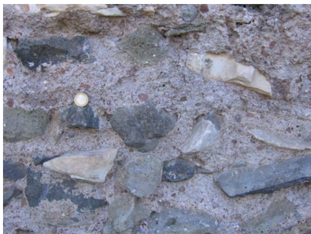
Fig. C-4 - Muratura con malta pozzolanica e pezzame di marmo, tufo e lava, alla base della Tomba di Cecilia Metella.
